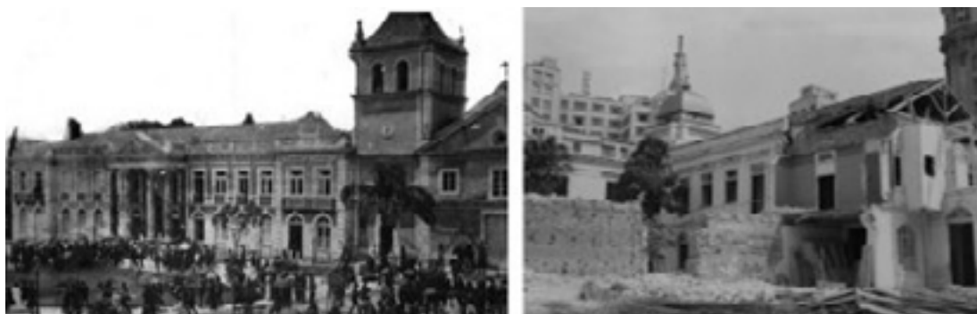
Figura 9. Respectivamente, estado do conjunto em 1891, após a reforma de Eusébio Stevaux (esq.) e processo de demolição do conjunto do Pateo do Colégio em 1953 (dir.) Acervo Museu Paulista, In Kuhn, 2016, p. 37(esq.); Sebastião A. Ferreira – Casa da Imagem, In Kuhn, 2016, p. 74 (dir.)
