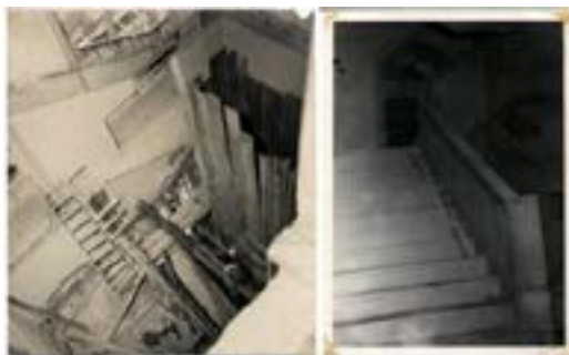
Figura 12. Fotografias do processo da obra de reformulação da bilheteria. Para tal, foi necessária a construção de um elevador (esq.) e de uma escada (dir.) destinados ao acesso direto do público do segundo setor da bilheteria aos assentos correspondentes, localizados na galeria e anfiteatro. Acervo de Fotografias do Arquivo Histórico Municipal de São Paulo.
